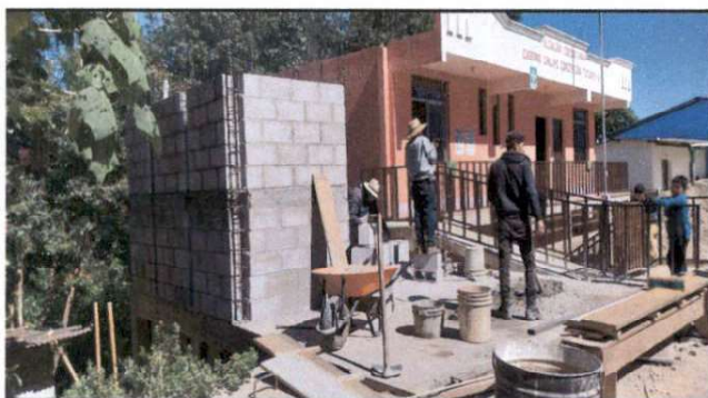
Foto 3: Mano de obra especializada
