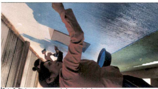
Foto 5: Pintura en muros exteriores e interiores
